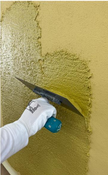
Appliquer l'enduit avec une taloche en inox et le tirer au grain
